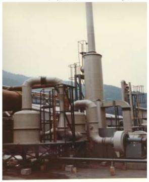
アルミニウム精錬における塩素処理工程から排出するヒューム、塩酸ガス及び塩素ガスの混合有害物質を、ベンチュリースクラバー、充填塔及び FRP 送風機の組み合わせによるシステム。
