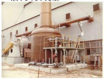
11. 塩酸酸洗ライン排ガス処理 鋼材に金属メッキを施す前の酸洗設備 からの排ガス処理装置。その他被メッ キ材料酸洗設備のガス処理の実績多数。
