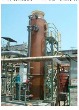
12. 粉体製品袋詰め工程の除塵装置 局所排気される空気中のヒュームをベン チュリースクラバーで除去するもので、 200m<sup>3</sup>/min 以下の物件については、実績 が多い。
