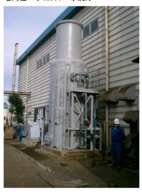
2. 複合廃棄物焼却炉排ガス処理 産業廃棄物を焼却した排ガスを冷却し、 SOX,HCl を吸収除去。苛性ソーダ水溶液 pH コントロールにより自動供給。
