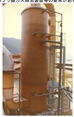
10. EGLメッキ液、硫酸ミスト含有排ガス 金属表面処理装置からの排ガス処理装置 ミスト濃度 200~300mg/Nm³→3~1mg/Nm³以下 ミストエリミネーターを適用する場合の 方が、多くなってきた。
